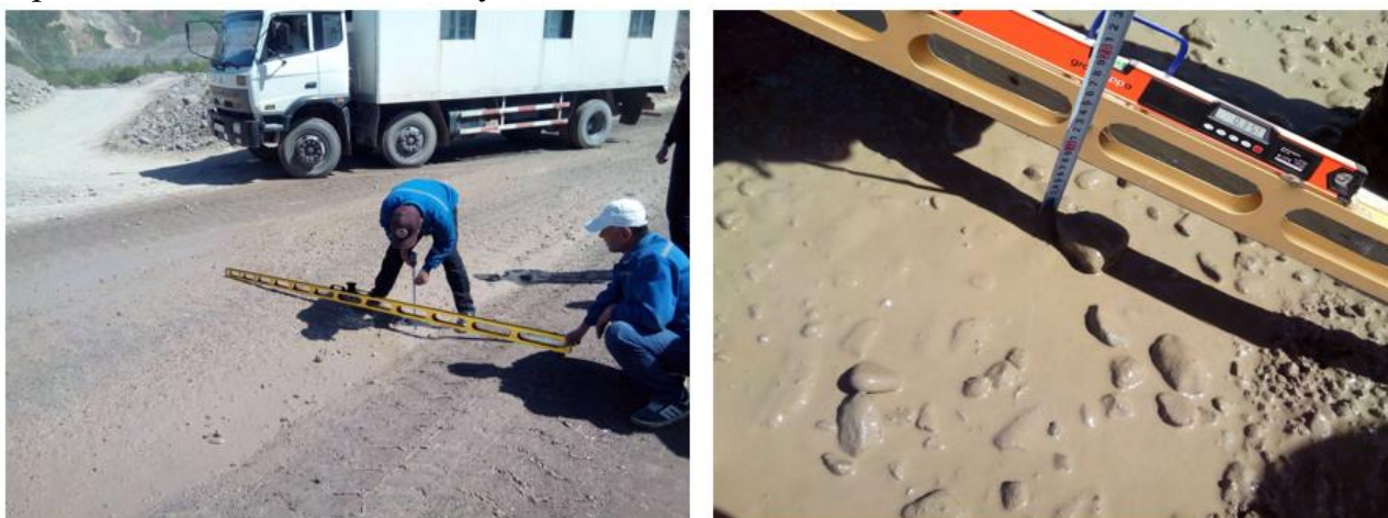
Рисунок 6 – Измерение неровностей карьерной дороги при помощи универсальной дорожной рейки РДУ-КОНДОР
