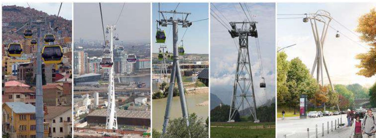
Рисунок 1.6 – Варианты конструктивного исполнения промежуточных опор [256]
