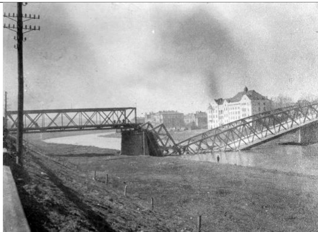
РГАКФД. Альбом 966. Виды Галиции, разрушений, причиненных войной. Снимок 23. Разрушенный железнодорожный мост. Б/м, б/д.
