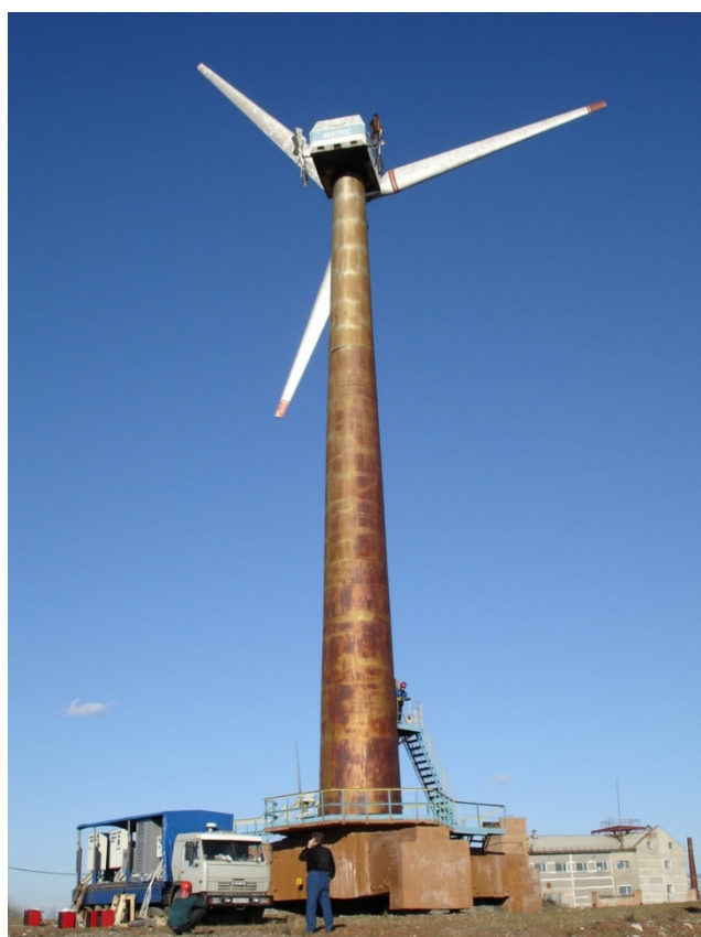
Рисунок 1.11 – МЭК на базе ВЭС «Заполярная» (г. Воркута) и инверторной ДГУ с ДВС 6ЧН13/14
