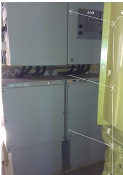
Рисунок 1.25 – Машинное отделение - шкаф БВА-3
